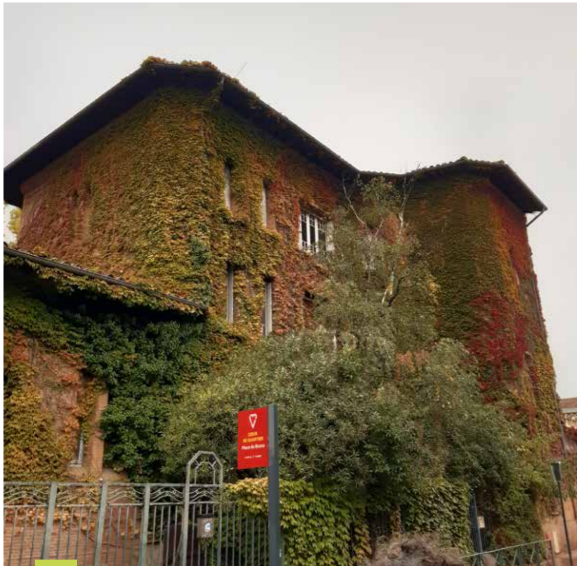
Bâtiment végétalisé - Toulouse
